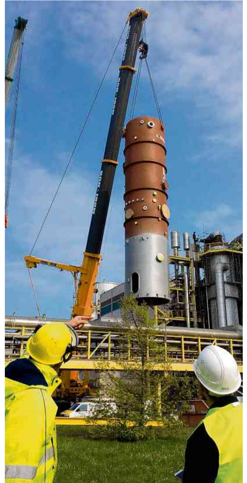
Jan Kunath (l.) und Manfred Hermanns überwachen die Installation. FOTO: RASCH
